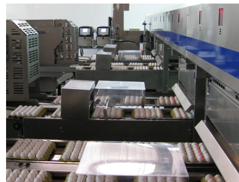
Drukarki CIJ zainstalowane w sortownicy
